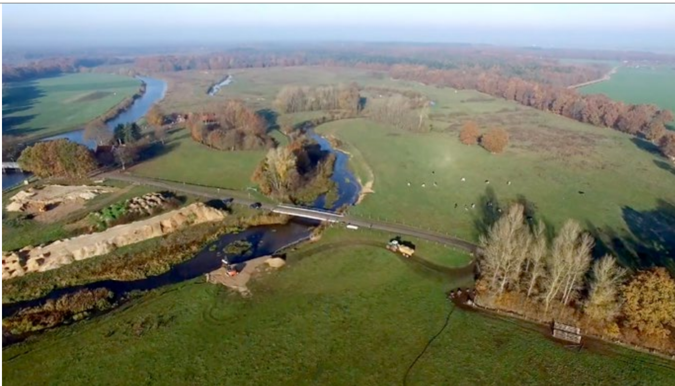
Zandsuppletie in een nevengeul van de Overijsselse Vecht moet ertoe leiden dat de beek het zand zelf afzet, waardoor de beekbodem omhoog komt, de stroomsnelheid afneemt en het waterpeil stijgt.
